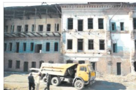
Ремонтные работы в самом начале
